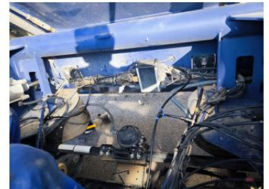
T CONECTADAS CON LOS TUBOS DE AIRE DE LA V. NIVELADORA
