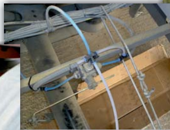
Conductos de aire
