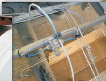
Conductos de aire
